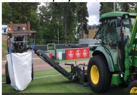
Før opptak av det gamle kunstgresset, ble all gummigranulat separert ut.
